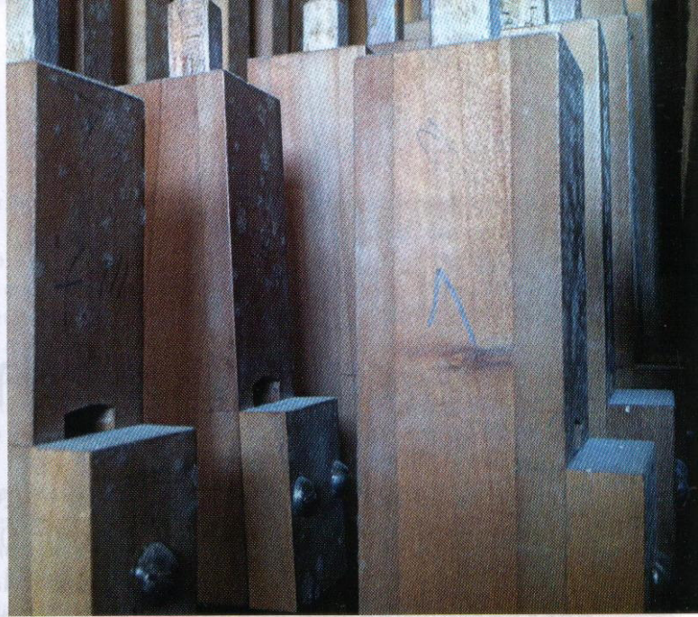
Sichtbarer Schimmelpilz an hölzernen Pfeifen
